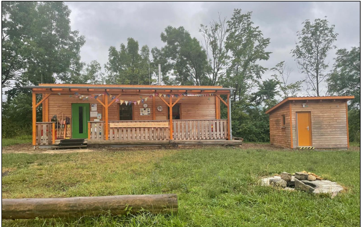
Abbildung 1: Schutzhütte und Sanitärhaus
