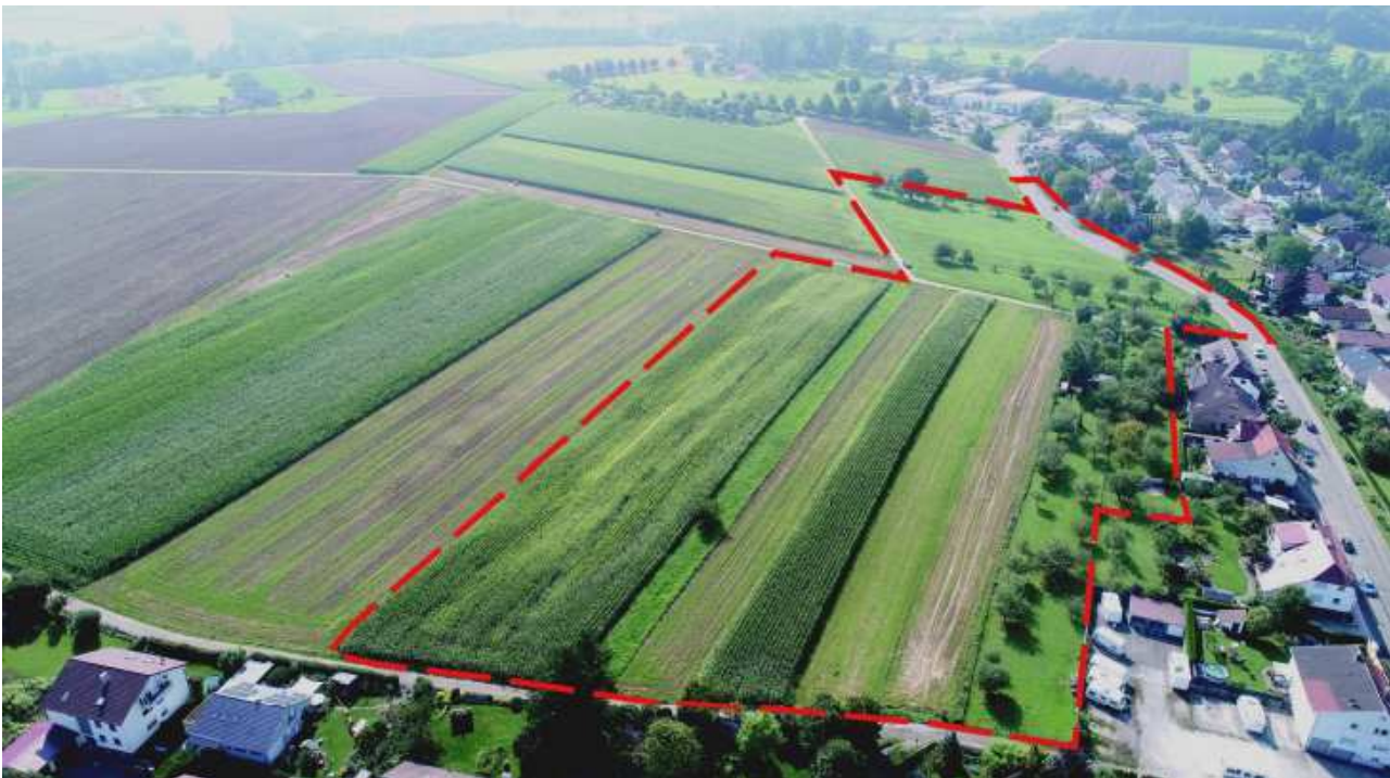
Abb. 1: Luftbild des geplanten Baugebietes vom 27.08.2019 (Blick Richtung Süden)
