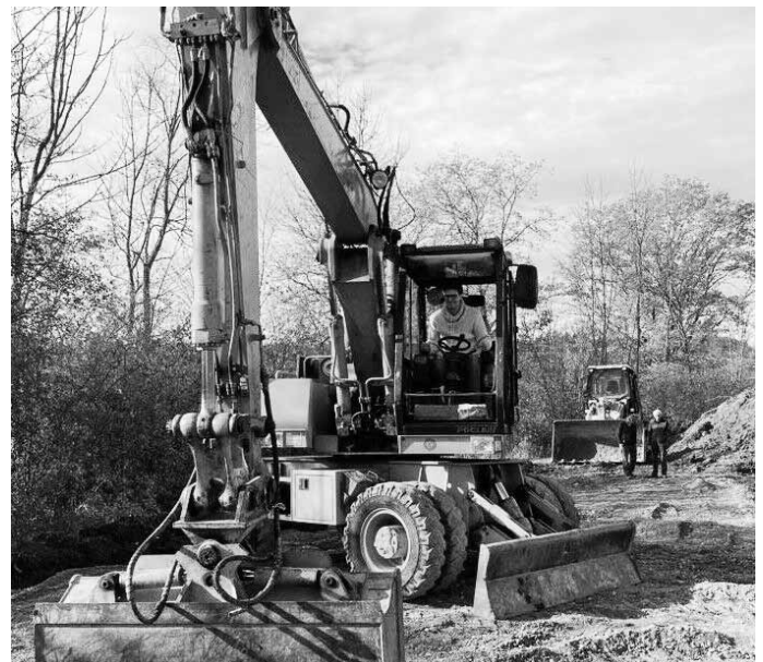
Bürgermeister Flik beim Spatenstich
