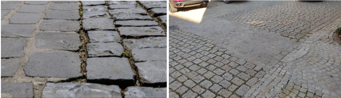
Abbildung 18: Beispiel für aufgefüllte Fugen von Pflasterflächen
