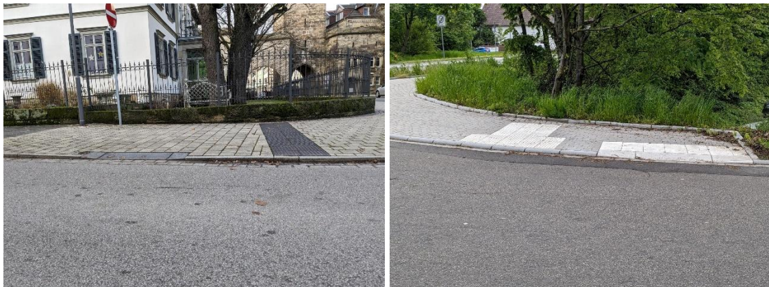
Abbildung 22: Beispiele für Bordsteinabsenkungen
