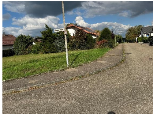
Abbildung 21: Fehlende Absenkung an der Einmündung Blumhardtweg
