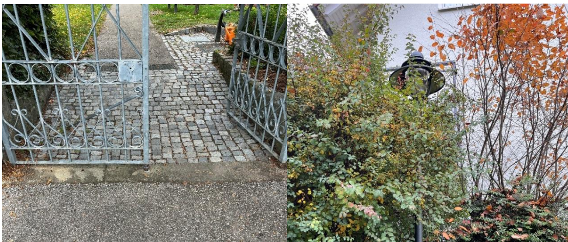
Abbildung 51: Eingangstor Friedhof; Bewuchs um Beleuchtung am Friedhofsweg
